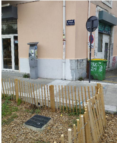
Figure 14 : Sur l'avenue de Vizille, les toitures ont été déconnectées dans les jardins de pluie créés sur l'espace public, grâce à une forte coordination interservices
