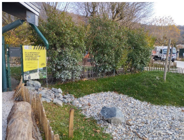
Figure 16 : La création de ce bassin sec a permis de déconnecter les eaux pluviales de la place aux enfants de la rue Claude Debussy à Poisat (travaux 2025)
