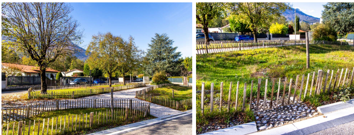
Figure 12 : Les retours d'expérience ont permis de montrer l'importance de soigner les zones d'écoulement vers les espaces verts, illustré ici sur l'îlot de la rue Georges Cuvier à Pont-de-Claix
