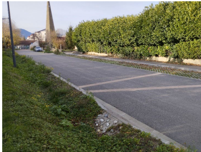
Figure 15 : La création d'une noue et la pose de revêtements perméables ont permis de déconnecter les eaux pluviales de la rue Félix Faure à St-Martin-le-Vinoux (travaux 2025)
